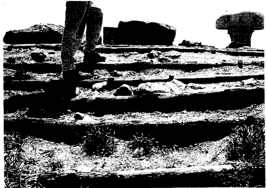
사진 11. 도화봉정상부 토양침식방지 복구공사후 모습 (92. 5)
