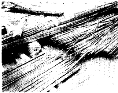
철근 절단 가공품 적치
