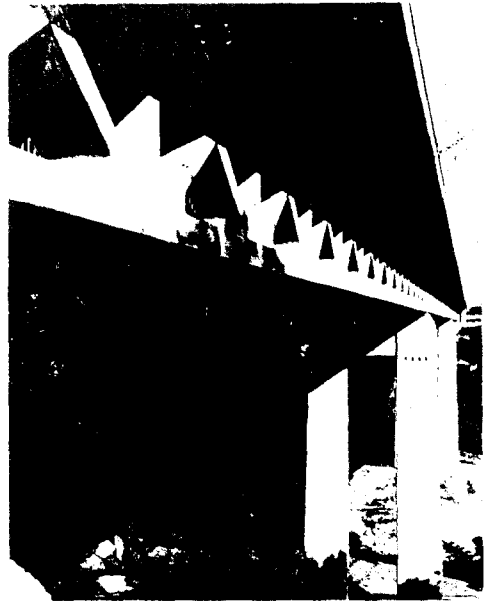
그림 11 독일의 뮌헨 근처의 Mangfall橋로서 90m-108m-90m의 3경간 연속교를 콘크리트 트러스橋로 1958~1960년에 완공하였다.
