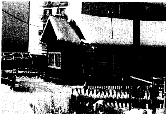
사진 2 지반의 동결 융해로 변형된 주택(사진 1의 국부확대)
