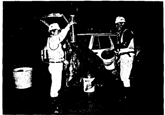
Photo 6. 벽면에서의 용수량 측정.
