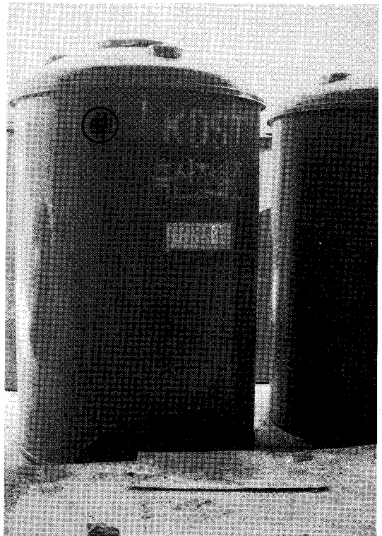
한국과학기술연구원이 개발한 축산정화조 이것은 낙농·육우 30두규모의 정화조(용량은 6㎡) 설치시간은 한나절이면 충분하다. 위의 ○부분이 축산분뇨의 입구, 정화된 분뇨를 배출하기 위해 반대편에 이정도 크기의 배출구가 있다.
