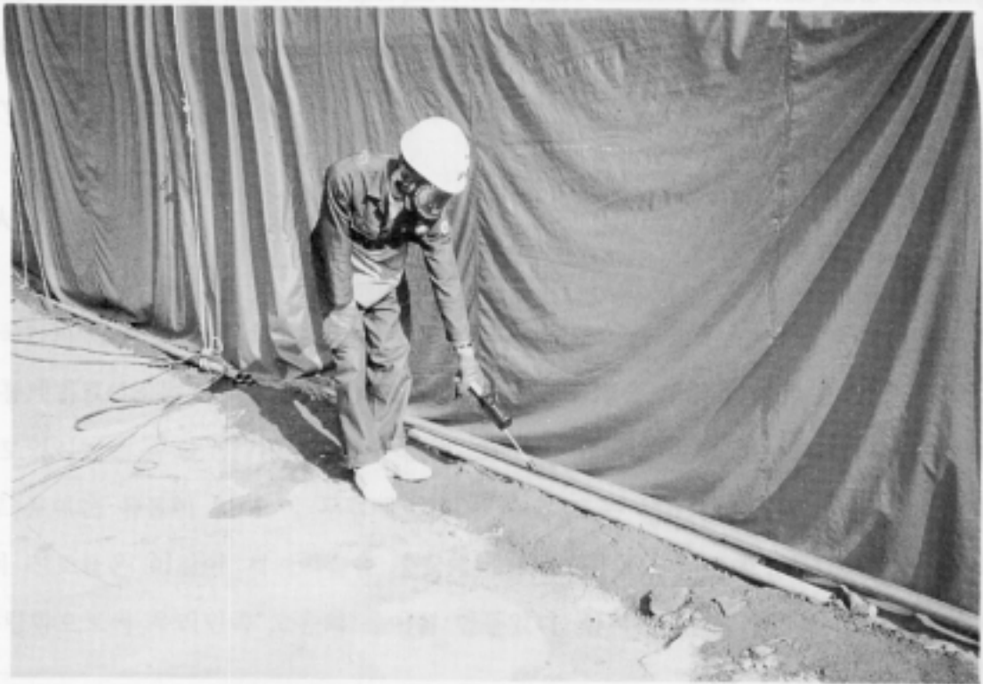
사진 4. 가스누출여부를 가스탐지기(Gas Leak Detector)로 점검
