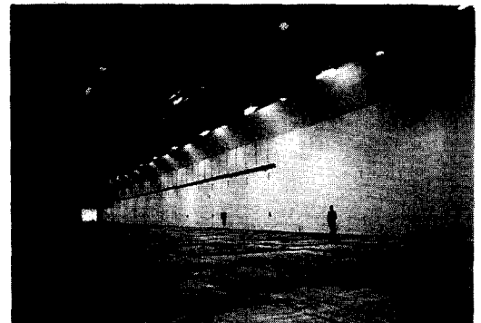
Fig. 30 Ammunition or dry storage in rock. (Fortifikasjon).
