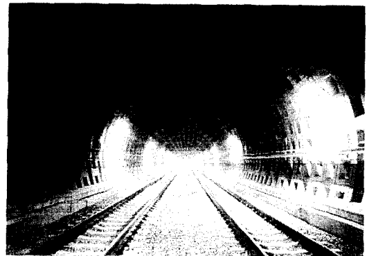
地下鐵 建設現況 및 計劃
