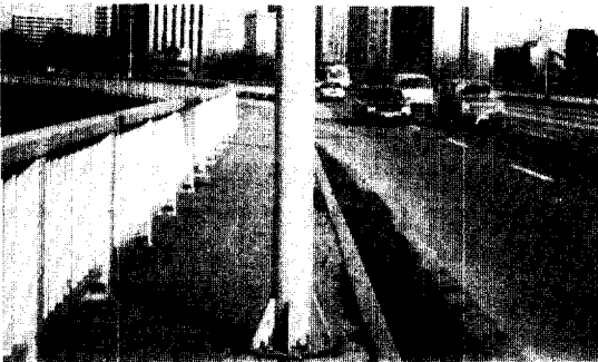
사진 1. 街路燈 콘크리트基礎不良
