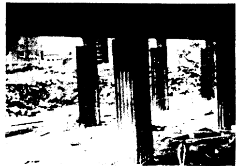
사진1. 기둥에 장약을 설치한 모습
