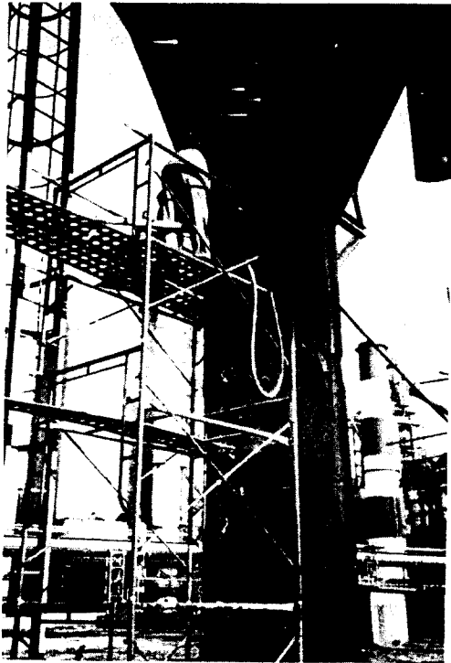
사진5. Head Tank 구조물의 천공 및 장악장면
