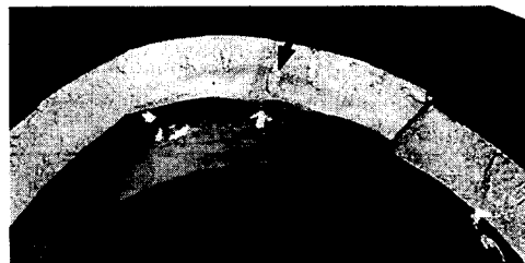
그림 8 균열 발생 부위의 확대 모습
