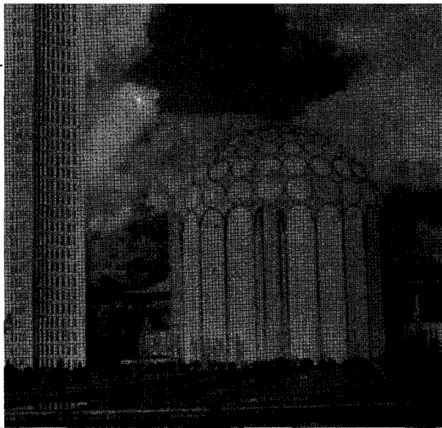
▲ PINSTECH 연구소의 연구로는 10MWt로 용량을 늘리고 20% 농축연료를 사용할 수 있도록 개조되었다.
