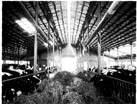
〈사진 39〉 오단지에 신축된 free stall 우사의 실내(건물선단 벽체를 sliding gate로 처리한 점이 돋보인다)
