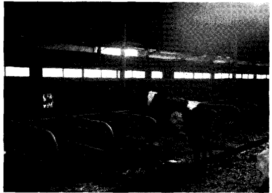
〈사진 11〉 1세대 후리스톨의 구조(직선배열형이며 우상구분대는 국내 처음으로 서스펜션 타입을 활용하였다)
