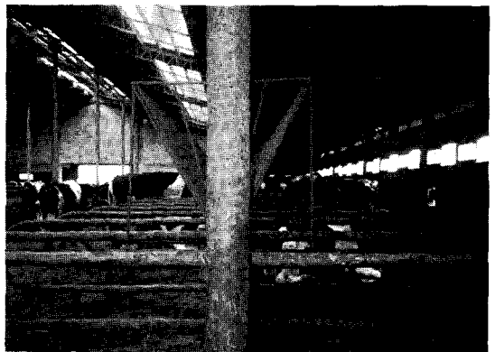
〈사진 12〉 환기시설을 개선한 모습(기존 창문위의 처마밑 환기구를 개방하였으며, 벽면에는 흡기구와 환풍기를 설치했고, 막혀있던 옹마루를 전체적으로 텅텅)
