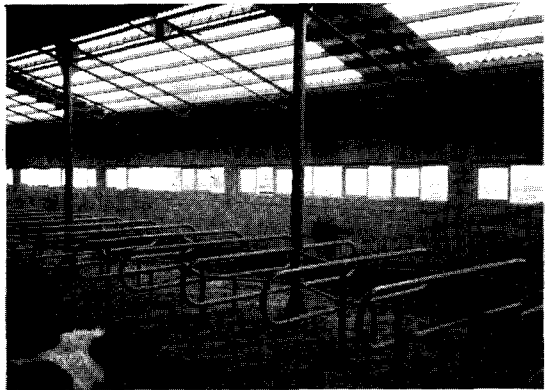
〈사진 15〉 지그재그 우상의 설치현장(젓소들이 불편없이 이 시설을 잘 이용하고 있으며 환기탕인지 우상의 건조상태가 좋았다)
