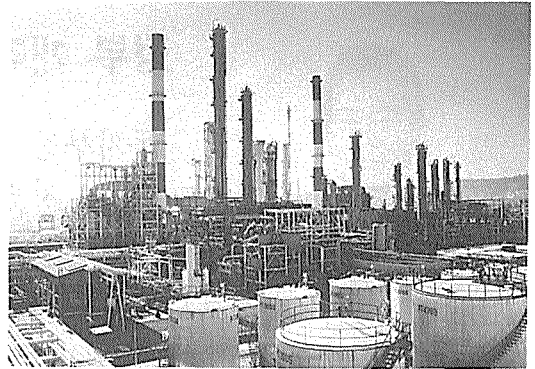
油公 제4 정유시설 전경
