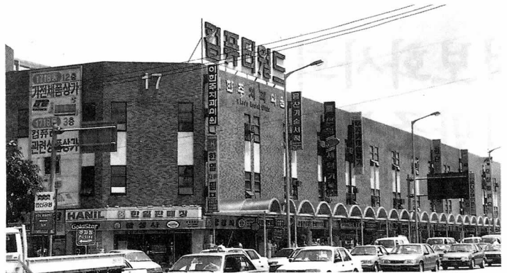
한국통신의 S/W유통센터가 들어설 나진상가. 한국통신은 이곳 지하 1층 739평규모에 국내 생산 소프트웨어만을 취급하게 될 유통센터를 설치, 오는 12월 오픈할 계획이다.
