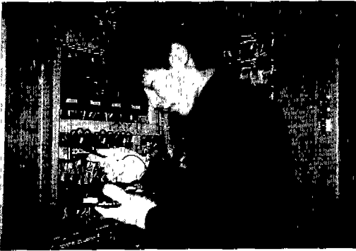
〈사진 2〉 공조기의 정격전류 및 전압측정 장면(2)
