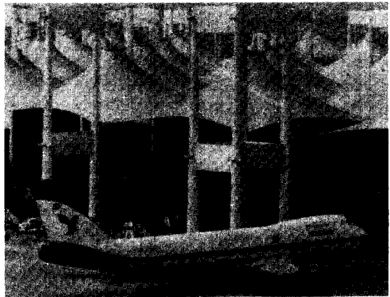
사진 3. Haj Terminal, Jeddah, Saudi Arabia
