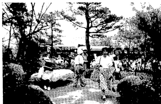
[사진 8] 산책로 부분<돌평상> 시공후 사진
