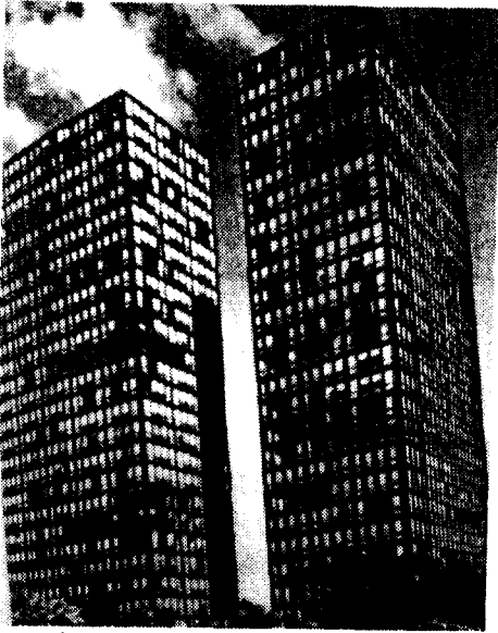
〈그림 8〉 Ludwig Mies Van Der Rohe, Lake Shore Drive Apartment(1951) History of Art P. 443
