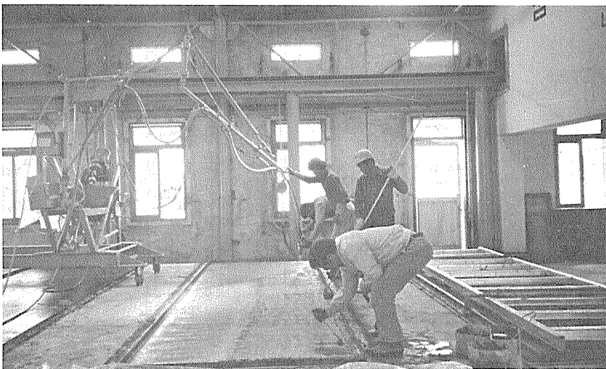
(사진-1) 직접분사공법의 제조광경
