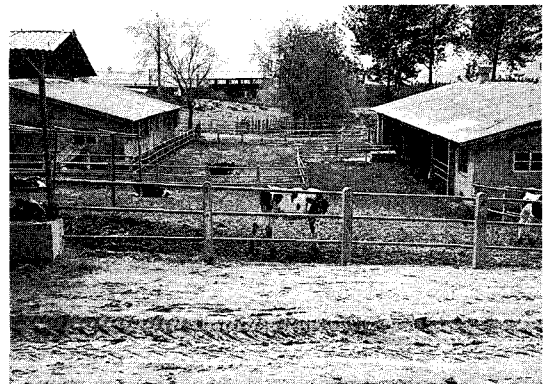
〈사진 3〉 구형 우사를 개조하여 만든 전면 개방형 송아지 우사
