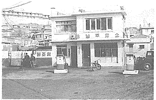
자동차가 ▶ 대중화되기 이전 '60년대의 한남주유소
