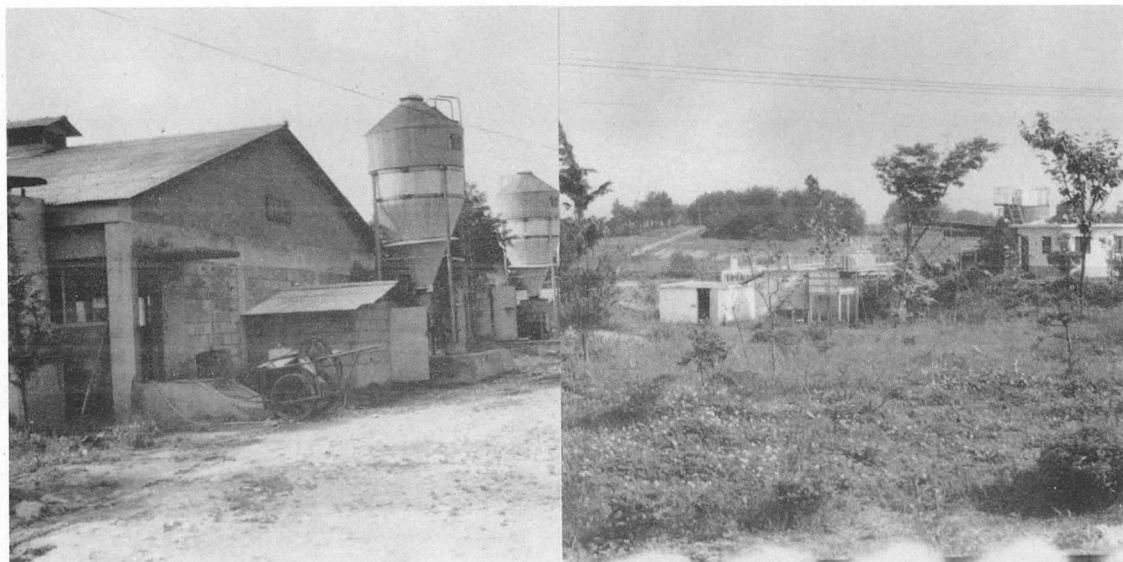
▲ 종업원들에게 양돈장을 양도기로 한 해태 종돈장 전경
