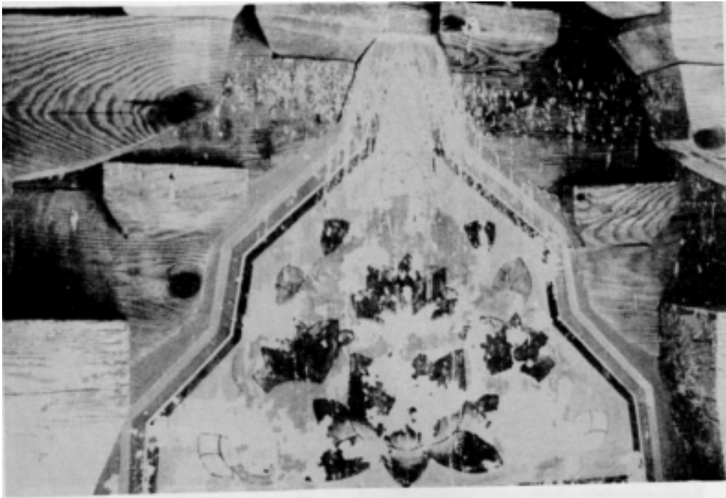
사진 7. 조류에 의한 피해상태 : 비둘기의 서식으로 벽화 표면이 오물로 오염되고 벽체가 허졌음.
