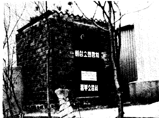
〈사진3〉 非常消防裝置
