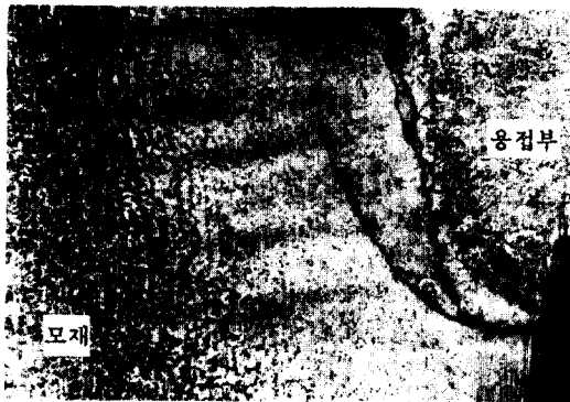
그림 9 용접 열영향부에 발생한 균열
