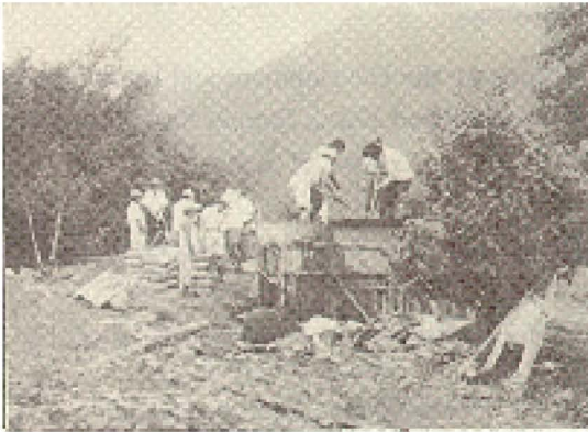
그림 6. 주민들에 의한 간이상수도시설 공사광경.
