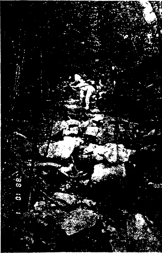
사진 32. 사다리벙창 등산로 노면세굴로 인한 암괴 노출(88. 10. 1)
