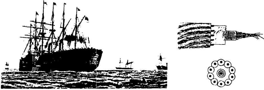
그림 1. 최초의 대서양횡단 해저전선 케이블과 이때 사용된 케이블선 (이때의 배는 증기선이었음)
