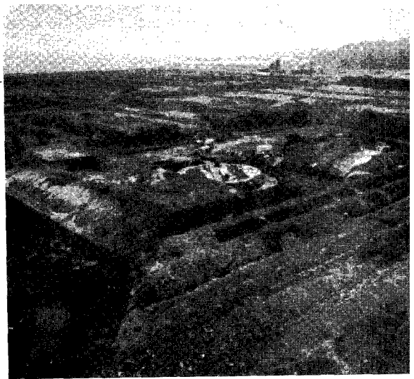
▲廣東原電 1次系統의 기초공사
