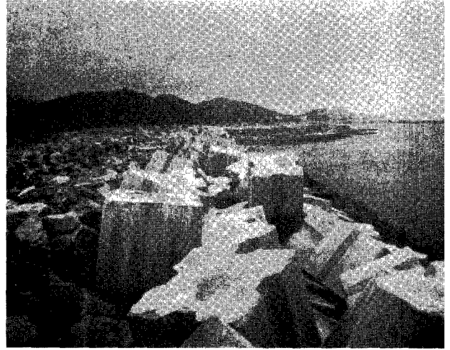
▲廣東原電敷地沿岸에 설치돼 있는 護岸用 콘크리트블록
