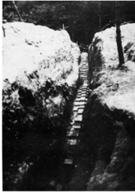
NO. 4 塙築排水溝를 덮은 흙을 파냄. 約 21m. (塙築排水溝를覆った土を排土. 約21米.)
