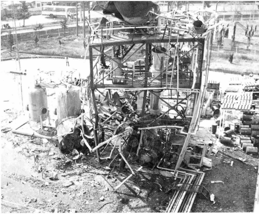
◀ 폭발사고현장 (폭발한 SO 3 저장탱크는 옆의 빈 탱크를 쓰러뜨리고 갈기갈기 찢긴 채 정제탑 상부에 얽혀있다.)
