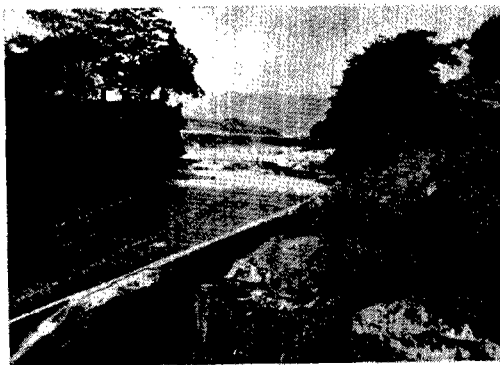
사진. 2. 扶餘 玉山貯水池의 放水路 破壞現場
