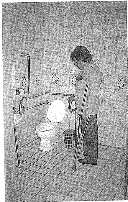
반기주변에 난간이 설치된 예, 장애자 전용화장실은 휠체어 사용을 고려하여 충분한 면적이 요구되며 수평 및 수직난간을 함께 설치한다.
