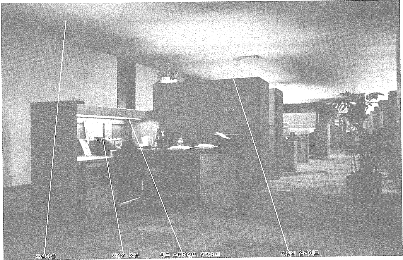
(사진 1) 어틀랜틱 리치필드회사(ARCO)의 데스크 엠비언트 조명방식
