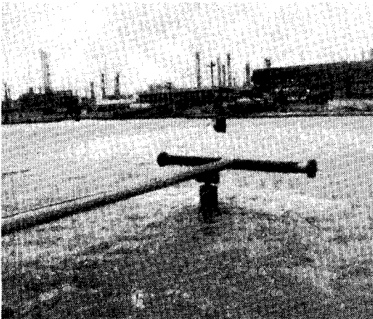
1978년에 설치된 폐수처리장
