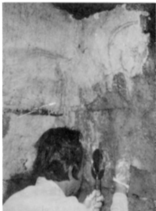
龜裂 및 粉狀剝落 부위를 接着시키는 상태
