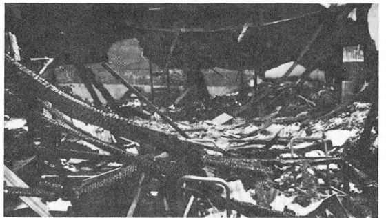
▲ 중앙상부에 보이는 구멍으로 화염이 건너와 공장등에 연소되어 목조건물 전체가 소실됨
