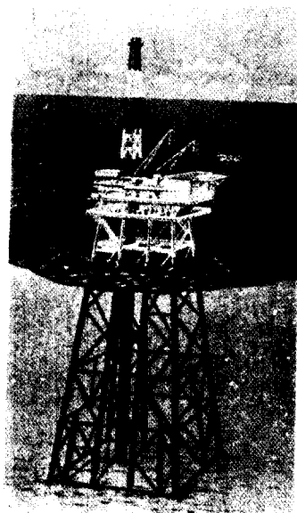
그림 21. 고정식 해양구조물, Platform 규모 8) (북해, 수심 360m)
