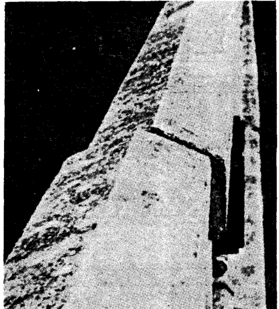
<그림-4> Parapet of the Val-dela-Mare dam
