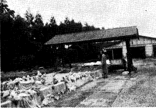
그림 2. 이 각형사일로는 단열로 되어 있고 사일로는 비닐을 덮어 빗물로서 공기의 차단과 중석(重石)의 효과를 갖추고 있다(일본에서 30두 규모의 낙농가).
