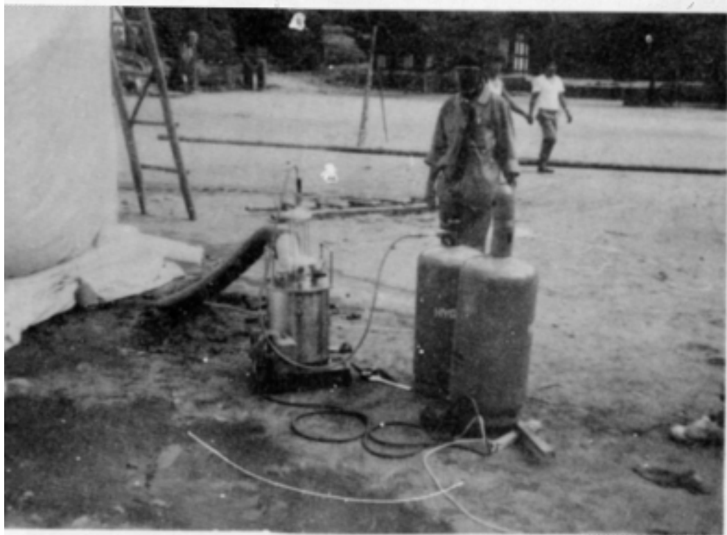
<사진 8> 기화기 설치
