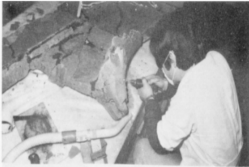
(사진 7). 缺損部の 充填된 面이 硬化된 後에 모타~롤키트를 使用, 表面을 練磨함.
