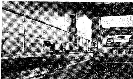
英國의 마르코니 커맨드 & 컨트롤社가 터널 내부등에 설치 일산화탄소에 대한 경보를 자동적으로 알려주는 자동공해감시 시스템을 개발했다. (그림)
