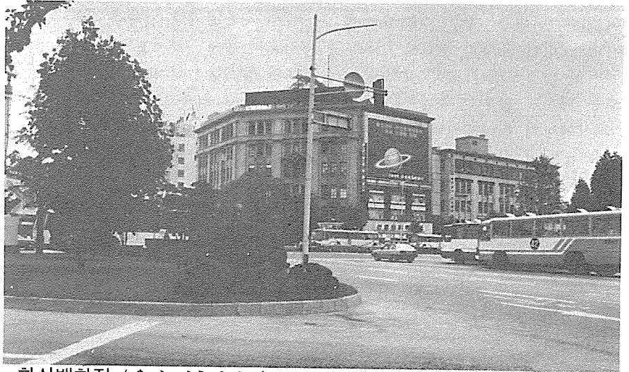
● 화신백화점 / 우리 건축가의 貴重한 作品. 철거 위협에 “전전공공”에처로워
