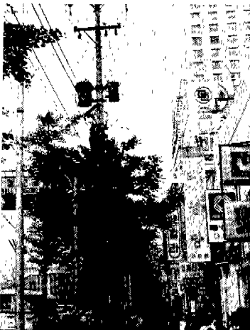
지중화 공사 전
