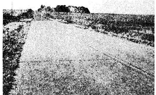
< 사진 - 7 > 美 아이오아州 郡道路에 있어서의 附着型 薄層 콘크리트 오우버레이한 施工例(이 寫眞은 훨씬 成功한 例이나 오우버레이와 동시에 擴幅하는 일이 많아서 새로로 갈라지는 부분이 생기게 것도 있다).
