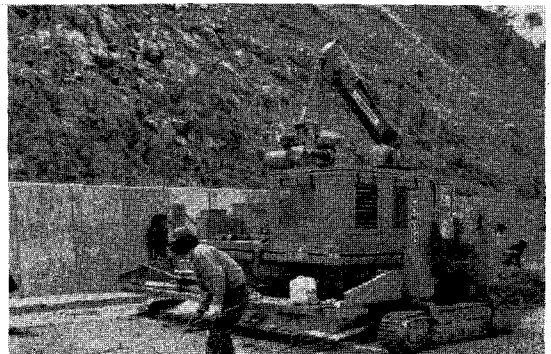
〈寫眞-3〉 GOMACO 自動 鋪設機
